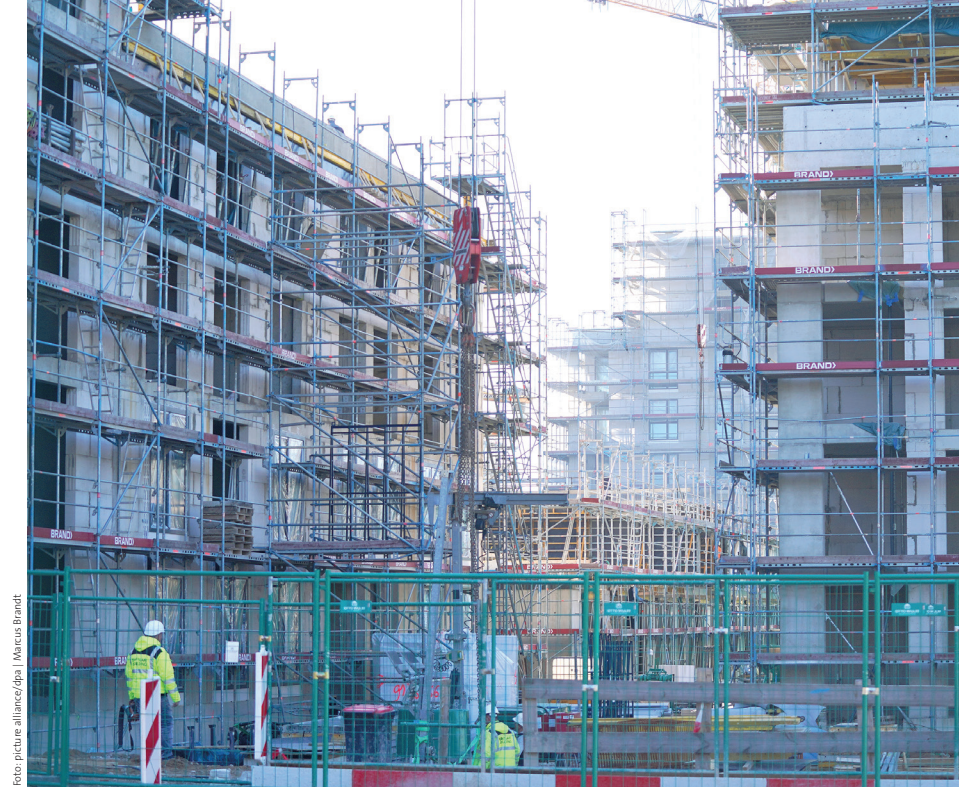
Bauarbeiter arbeiten auf der Baustelle des neuen Stadtquartiers Kolbenhöfe in Hamburg-Ottensen.
