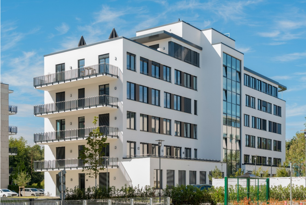
Büro- und Verwaltungsgebäude, Neu-Isenburg (Hessen)
